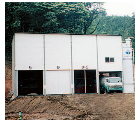
バッチャープラント
